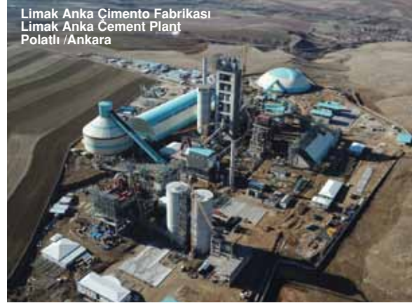
Limak Anka Çimento Fabrikası Limak Anka Cement Plant Polatlı /Ankara
