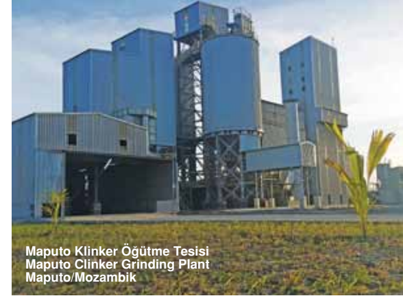
Maputo Klinker Öğütme Tesisi Maputo Clinker Grinding Plant Maputo/Mozambik paketleme fabrikalarının kurulumunu ve klinkerin dışarıdan teminini daha efektif hale getiriyor. Bunun sonucu olarak da iç piyasada ihtiyaç fazlası olan klinkerin satışı için iyi bir pazar imkanı yaratılıyor. Tabii burada fabrikanın lokasyonu ve klinker maliyetleri de göz ardı edilemeyecek hususlar.
